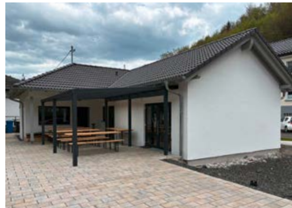
Das neue Grubenhaus dient dazu, auf Führungen vorzubereiten, Sicherheitshinweise zu geben und Schutzausrüstungen zu verteilen – inklusive Mehrzweckraum und barrierefreiem Sanitärbereich.
