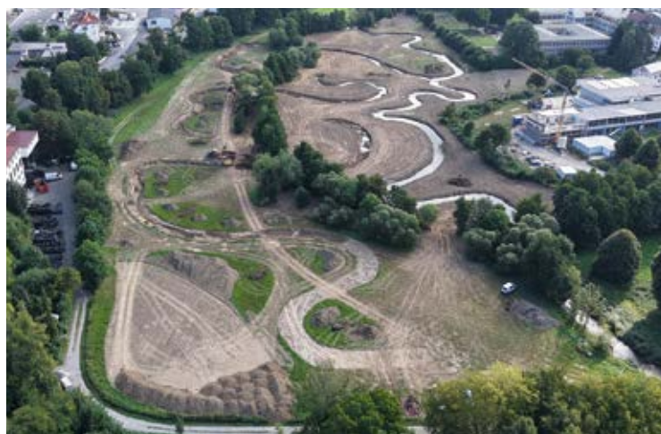
Gewunden statt schnurgerade: In nur vier Monaten Bauzeit wurden die Baumaßnahmen abgeschlossen.
